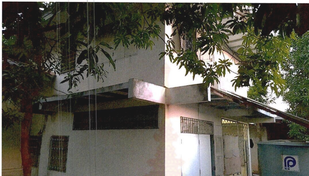
ภาพที่ 60 แสดงให้เห็นถึงแผงกันสาดคานยื่น
