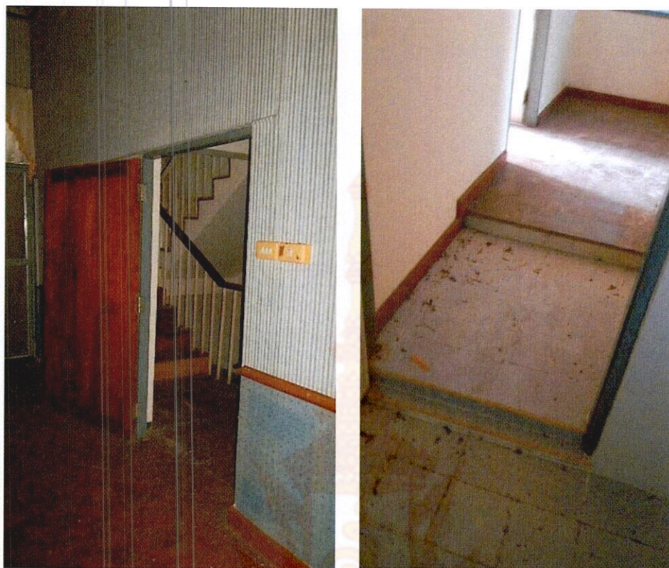
ภาพที่ 62 แสดงให้เห็นถึงโครงสร้างพื้นภายในอาคารชั้นล่าง
