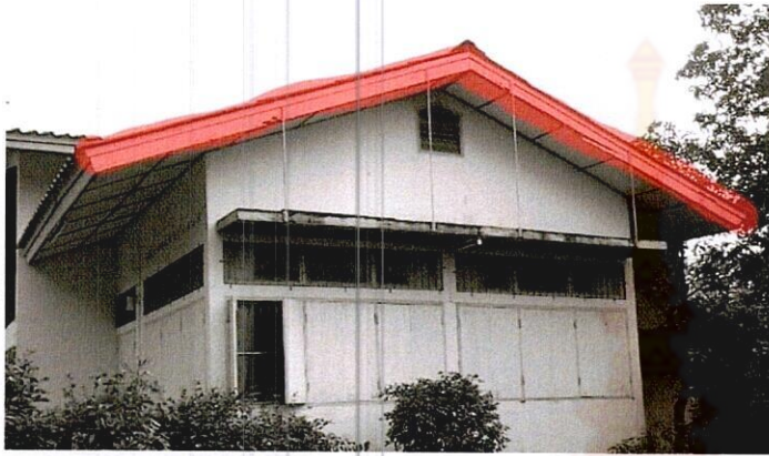
ภาพที่ 32 แสดงความเสียหายในส่วนของไม้เชิงชาย
