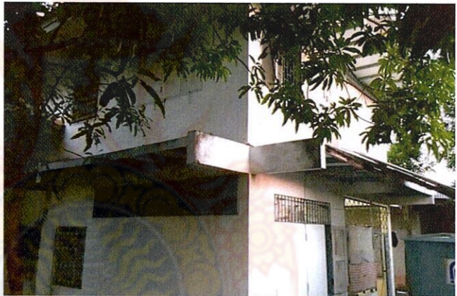
ภาพที่ 55 แสดงรูปแบบแผงกันสาดโครงไม้ เหนือหน้าต่าง
