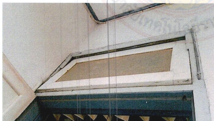
ภาพที่ 51 แสดงรูปแบบช่องแสงบานกระทุ้ง
