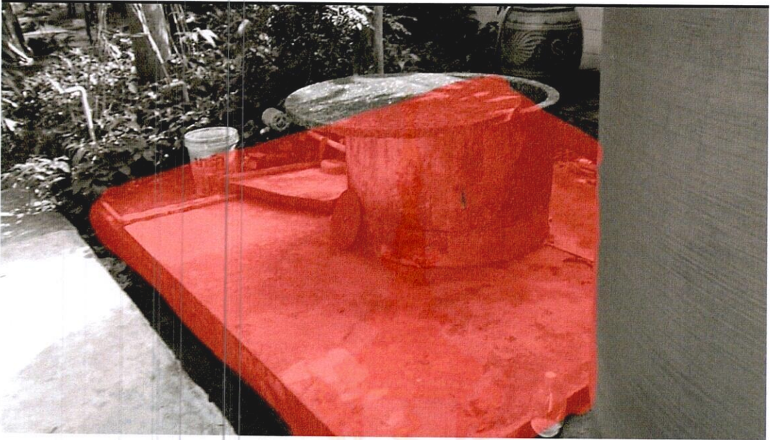
ภาพที่ 38 แสดงความเสียหายจากน้ำที่ขังทำให้พื้นทรุดตัว
