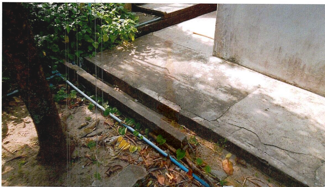
ภาพที่ 16 แสดงคูระบายน้ำรอบตัวบ้าน
