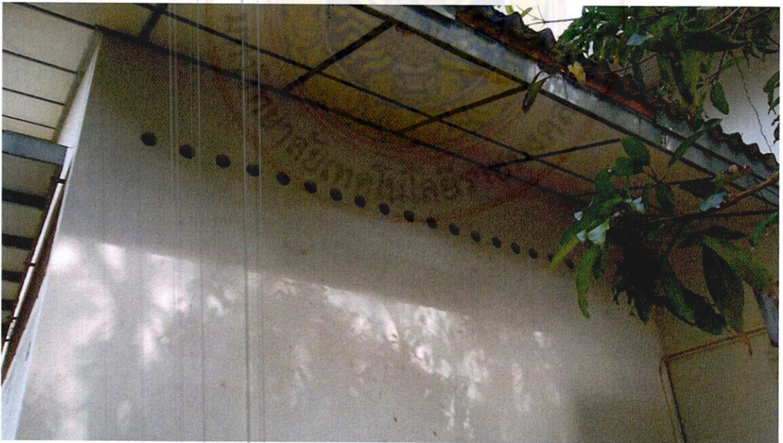
ภาพที่ 13 แสดงการเจาะผนังเพื่อระบายอากาศ
