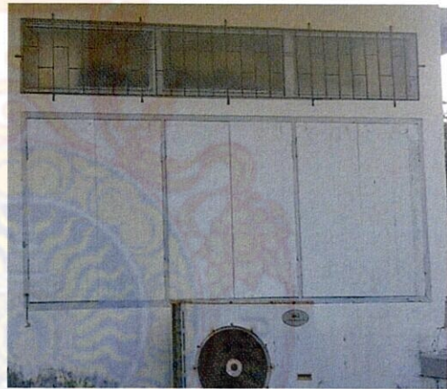
ภาพที่ 48 แสดงรูปแบบหน้าต่างไม้บานเปิดคู่สามช่องมีช่องแสงด้านบน
