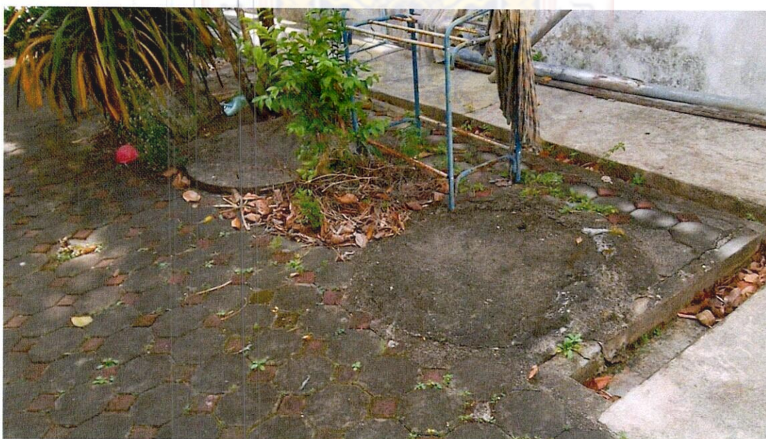
ภาพที่ 17 แสดงคูระบายน้ำรอบตัวบ้าน
