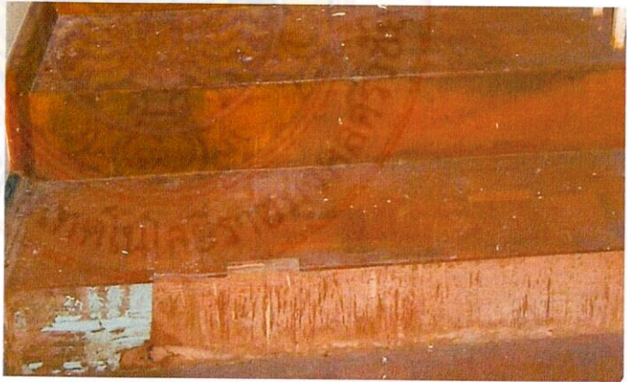
ภาพที่ 39 แสดงความเสียหายปลวกกินเนื้อไม้
