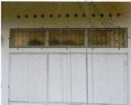
ภาพที่ 53 แสดงรูปแบบช่องระบายอากาศ บริเวณผนังอาคาร
