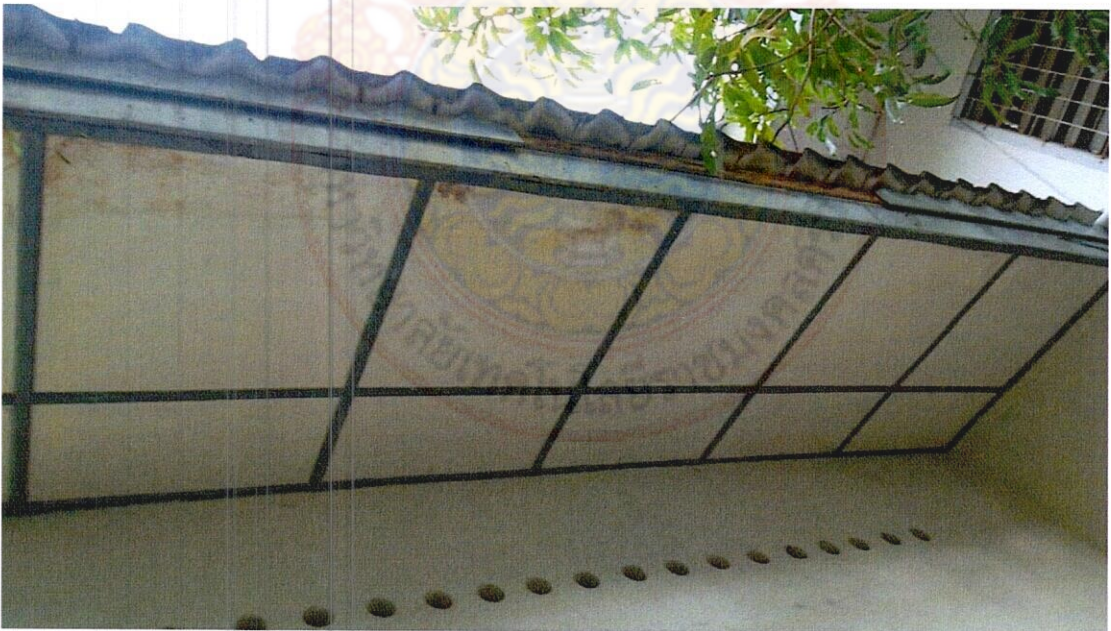
ภาพที่ 33 แสดงความเสียหายในส่วนของไม้เชิงชาย
