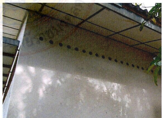
ภาพที่ 53 แสดงรูปแบบช่องระบายอากาศ บริเวณผนังอาคาร
