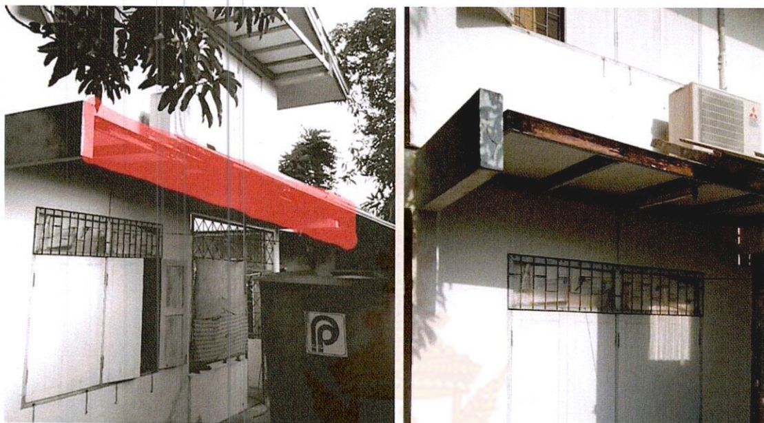
ภาพที่ 30 แสดงความเสียหายในส่วนของโครงแผงกันสาด
