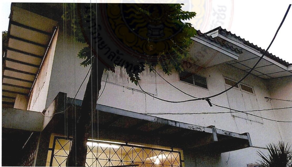
ภาพที่ 19 แสดงรูปแบบแผงกันสาดชั้นล่าง
