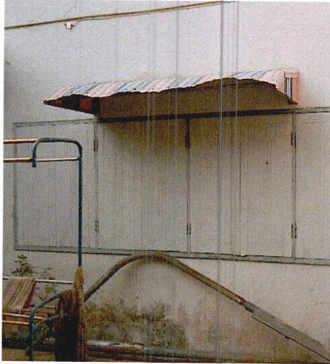
ภาพที่ 36 แสดงความเสียหายในส่วนของการปรับปรุงต่อเติมกันสาด
