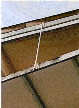
ภาพที่ 56 แสดงรูปแบบการใช้เหล็กยึดแผงกันสาด
