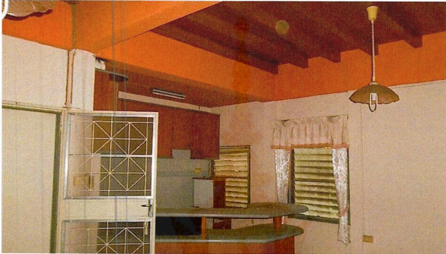
ภาพที่ 67 แสดงให้เห็นถึงโครงสร้างพื้นภายในอาคารชั้นบน
