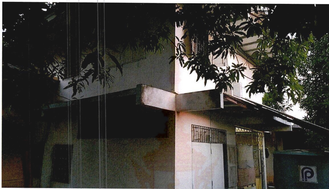
ภาพที่ 18 แสดงรูปแบบแผงกันสาดชั้นล่าง
