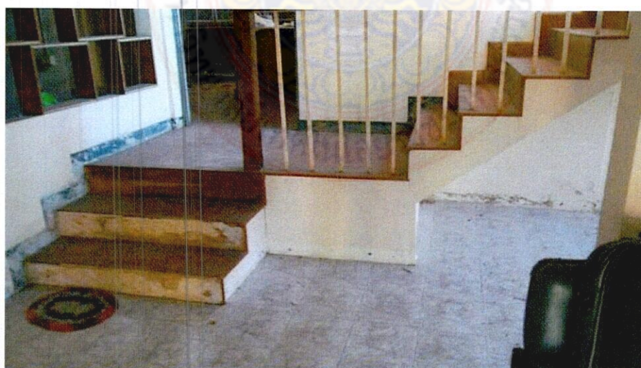
ภาพที่ 61 แสดงให้เห็นถึงระดับพื้นภายในอาคารชั้นล่าง
