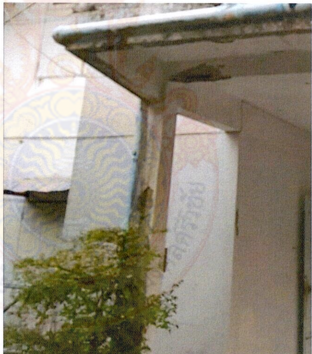
ภาพที่ 27 แสดงความเสียหายในส่วนของโครงสร้างอาคาร เสาคอนกรีต และคานคอนกรีต
