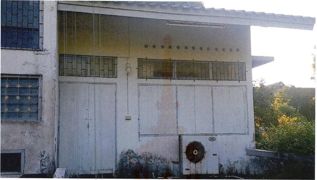
ภาพที่ 12 แสดงรูปแบบการเจาะช่องระบายอากาศ ฝั่งทิศตะวันออกของอาคาร
