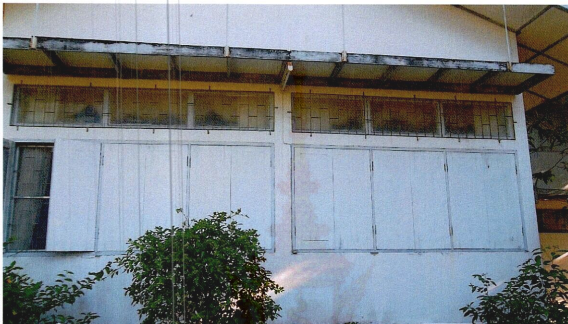
ภาพที่ 20 แสดงรูปแบบแผงกันสาดใต้หลังคา
