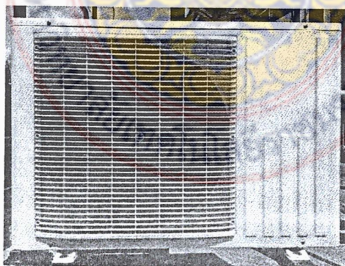
รูปที่ 3.10 ชุดระบายความร้อน (12000 BTU)
