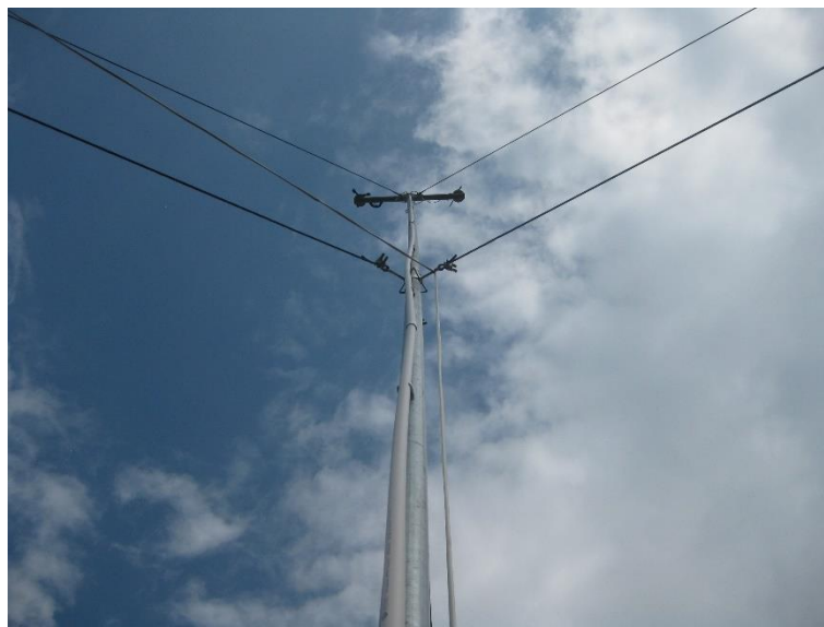
ภาพที่ 2.7 เสาเหล็กสำหรับติดตั้งเซนเซอร์วัดสภาพแวดล้อม
