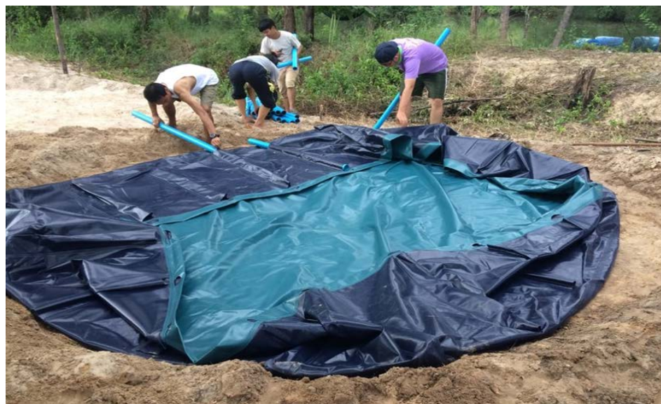
ภาพที่ 2 - 2 การเตรียมบ่อผ้าใบเพื่อใช้เป็นบ่อเพาะเลี้ยงกุ้งและบ่อบำบัดสำหรับปรับปรุงคุณภาพน้ำ
