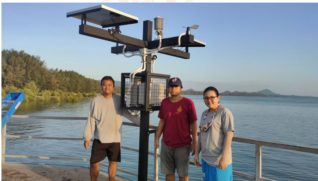
ภาพที่ 3.4 โครงสร้างชุดตู้ควบคุมด้านข้าง
