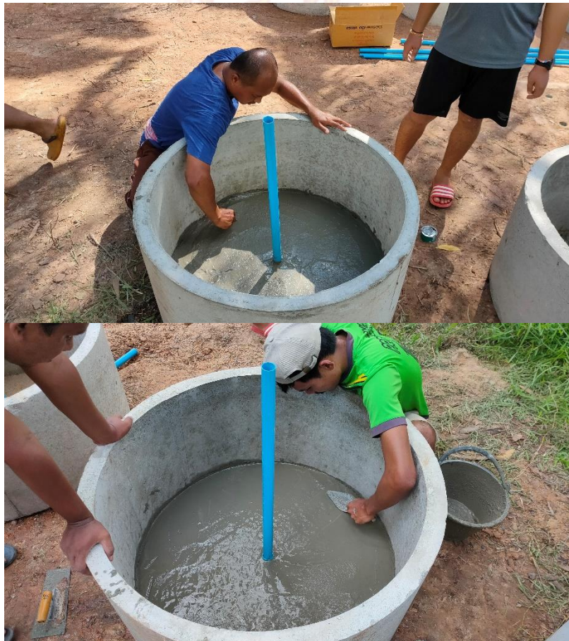
ภาพที่ 3.9 การฉาบปูนเพื่อสร้างบ่อเลี้ยงหอยขม
