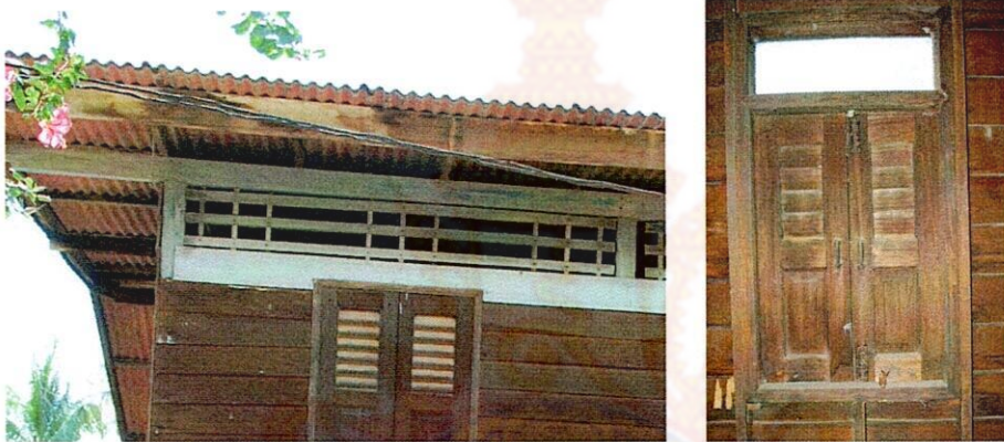
ภาพประกอบที่ 3.63 แสดงลวดลายบริเวณคอสองชั้นบน และบานหน้าต่างชั้นบน
