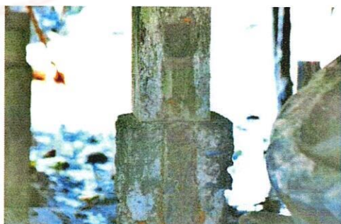
ภาพประกอบที่ 3.26 แสดงบันไดไม้ และตีนเสาคอนกรีต
