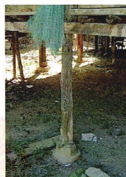
ภาพประกอบที่ 3.58 แสดงผนังไม้ตีซ้อนเกล็ดแนวนอน และตีนเสาคอนกรีต
