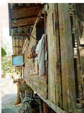
ภาพประกอบที่ 3.58 แสดงผนังไม้ตีซ้อนเกล็ดแนวนอน และตีนเสาคอนกรีต
