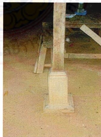
ภาพประกอบที่ 3.40 แสดงเสาและฐานไม่ยึดติดกับ พื้นสามารถเคลื่อนย้ายได้
