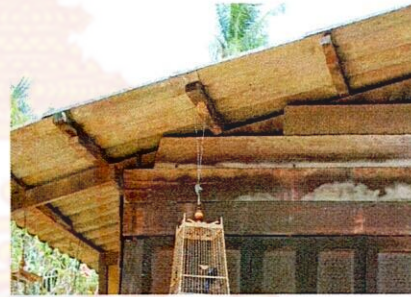
ภาพประกอบที่ 3.32 แสดงโครงสร้างหลังคาไม้ และกระเบื้องมุงหลังคา
