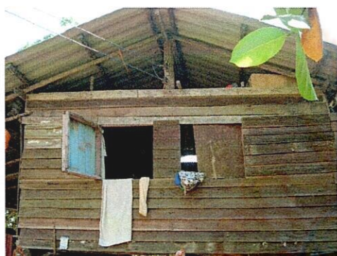
ภาพประกอบที่ 3.58 แสดงผนังไม้ตีซ้อนเกล็ดแนวนอน และตีนเสาคอนกรีต
