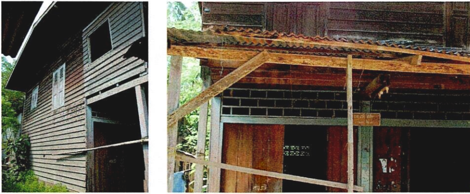
ภาพประกอบที่ 3.62 แสดงผนังไม้ตีซ้อนเกล็ดแนวนอน และลวดลายบริเวณคอสองชั้นล่าง
