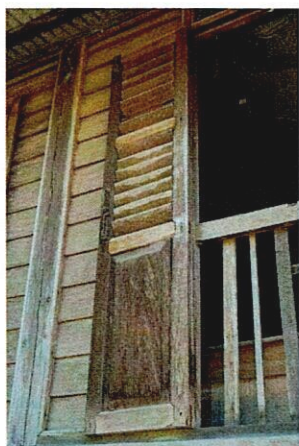
ภาพประกอบที่ 3.47 แสดงหน้าต่างแบบยาวจรดพื้น และตีนเสา, เสาคอนกรีตไม่ได้ฝังลงดิน
