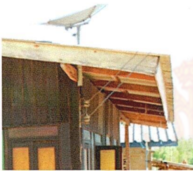
ภาพประกอบที่ 3.32 แสดงโครงสร้างหลังคาไม้ และกระเบื้องมุงหลังคา
