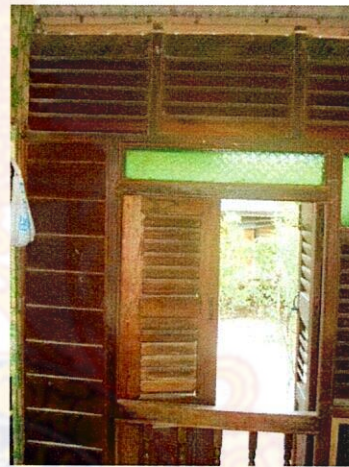
ภาพประกอบที่ 3.38 แสดงบนขอบหน้าต่างมี ช่องแสงนิยมใช้กระจกเป็นสี
