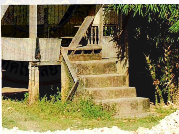
ภาพประกอบที่ 3.54 แสดงหน้าต่างบานเกล็ด และบันไดคอนกรีต
