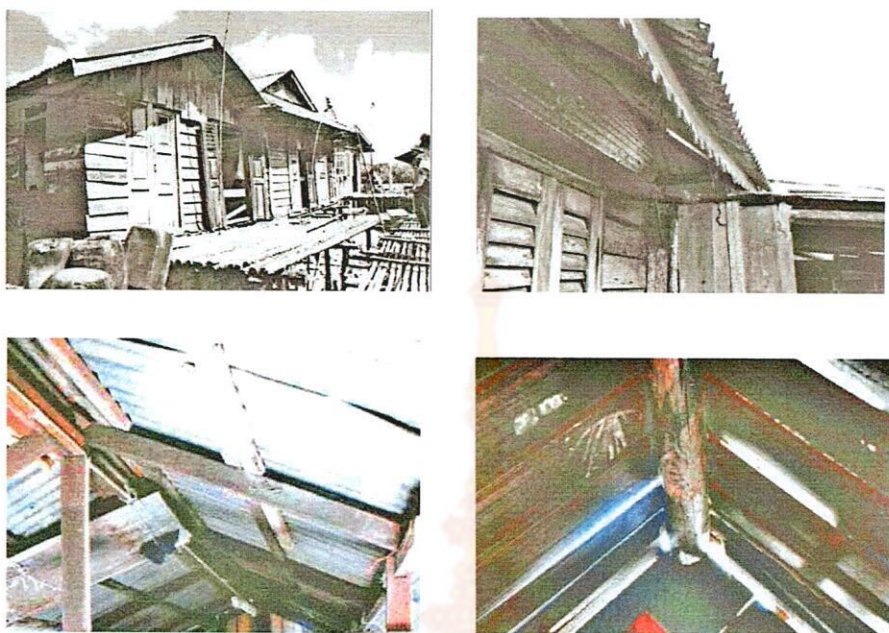
ภาพประกอบที่ 3.19 แสดงเกลียวด้านข้างของเรือน. ชายคายื่น และองค์ประกอบส่วนหลังคา
