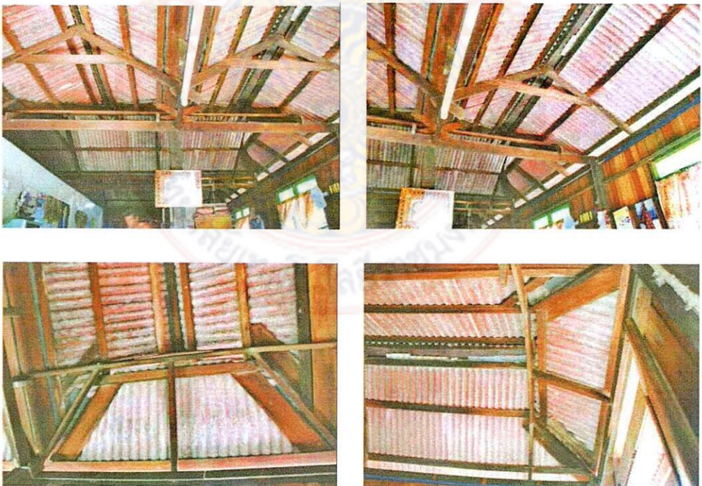
ภาพประกอบที่ 3.28 แสดงองค์ประกอบโครงสร้างหลังคา
