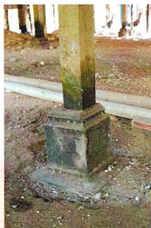
ภาพประกอบที่ 3.47 แสดงหน้าต่างแบบยาวจรดพื้น และตีนเสา, เสาคอนกรีตไม่ได้ฝังลงดิน
