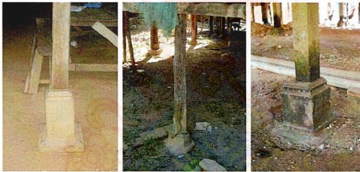
ภาพประกอบที่ 4.1 แสดงตีนเสาคอนกรีตเรือนพื้นถิ่นตำบลปุย อำเภอมือง จังหวัดสตูล
